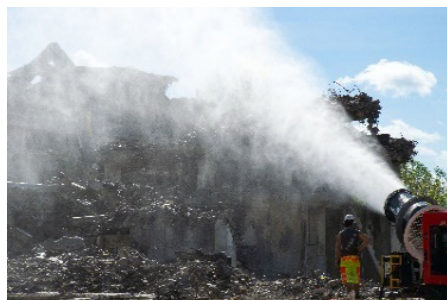
Fig. 8.3.10 Wetting Down Dust
