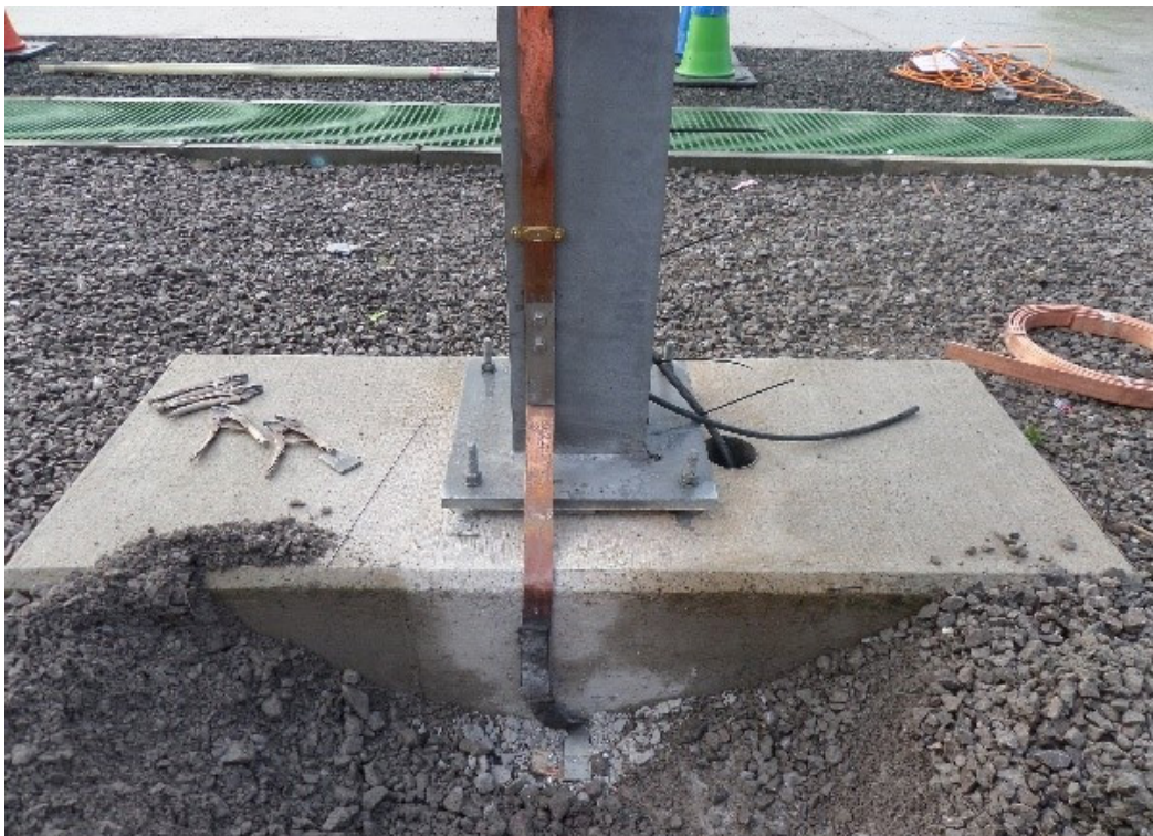
Fig. 5.1.40 Earth electrode
