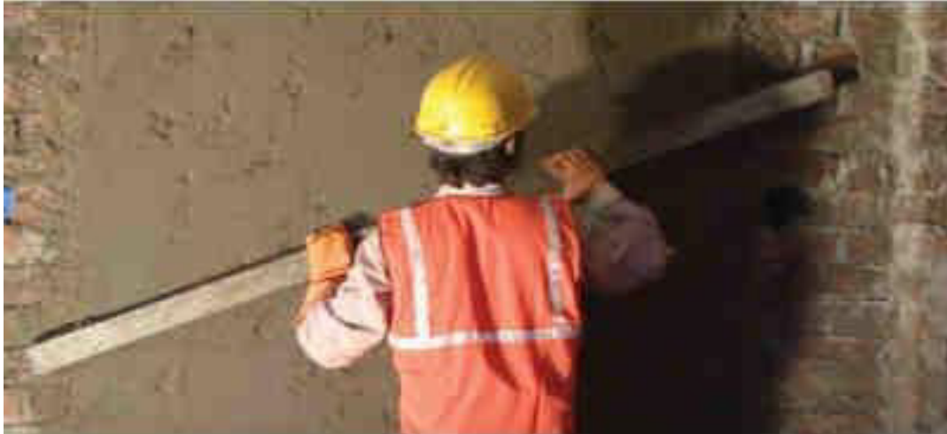
Fig. 10.1.1 Mason Plastering
