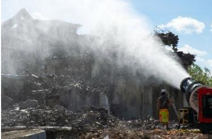
Fig. 5.3.10 Wetting Down Dust
