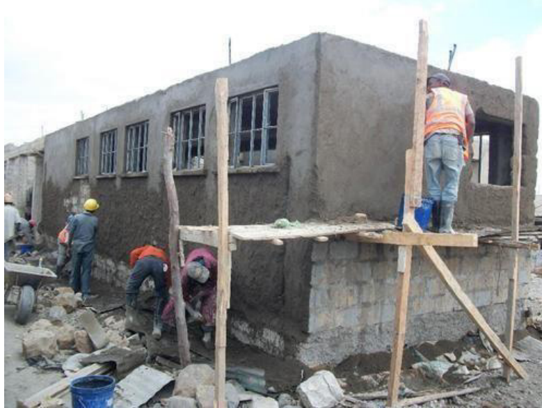
Fig. 10.1.1 Mason Plastering
